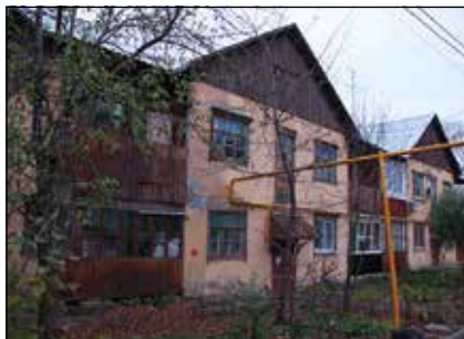
ул. Красноармейская, 137а
